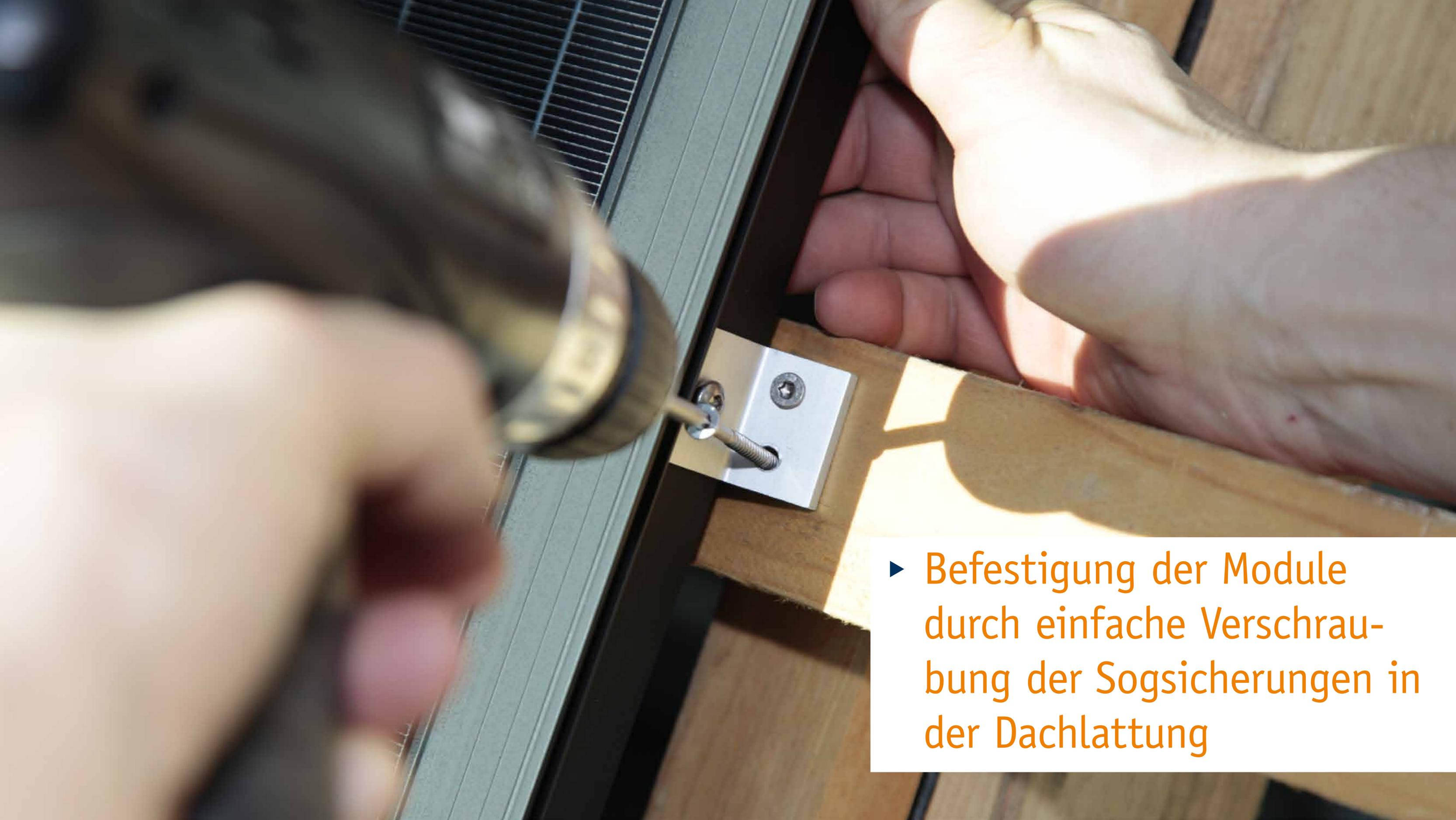
► Befestigung der Module durch einfache Verschraubung der Sogsicherungen in der Dachlattung
